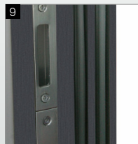
Przegroda termiczna z jedną uszczelką w skrzydle oraz dwoma w ościeżnicy
