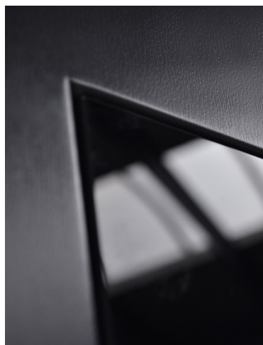
Zlicowanie szyby od strony zewnętrznej
